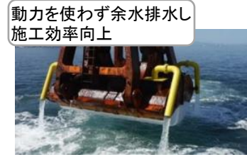
東洋建設・ サイホン式余水排水工法
