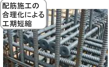
清水建設・Tヘッド工法鉄筋
